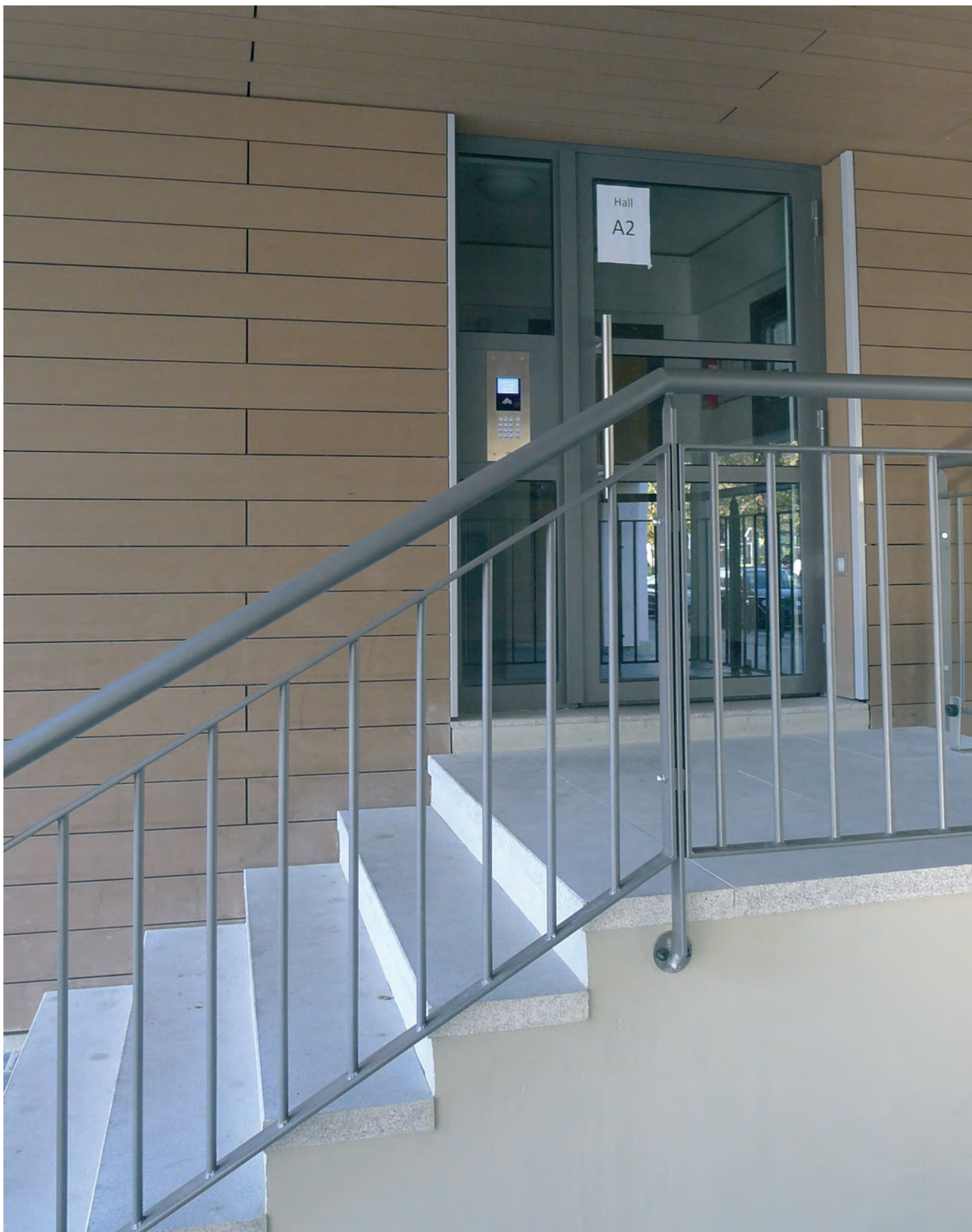
Sécurisation des entrées à La Courneuve lors de la réhabilitation (OGIF)
