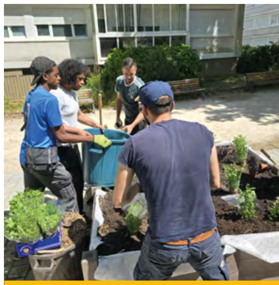
Chantier jeunes, création de bacs et plantation - Les Ulis (Seqens)
